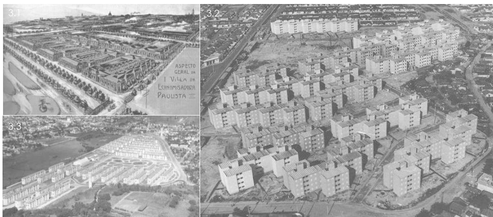
Fotografia 3.1 – Panfleto publicitário da Vila Economizadora em São Paulo, edificada em 1908 com o intuito de alojar operários da Indústria têxtil.
