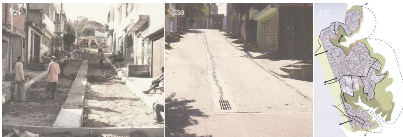
Fotografia 5.29 – Cantinho do Céu – sistema de drenagem e viário em construção.
